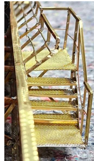
Riffelblech, Treppe und Geländer
