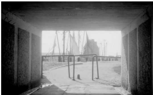
Hafentunnel mit Blick zum Außenhafen um 1965 (Foto WestküsteNet)
