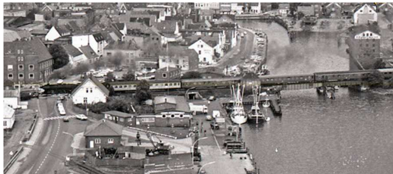
Husumer Klappbrücke Blick vom Außenhafen mit Bahnübergang um 1970
